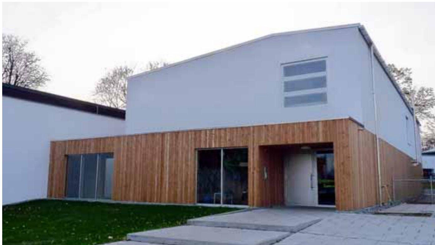
Ein moderner, angenehmer Aufenthaltsort ist das rundum erneuerte Kinderhaus Sonnenschein in Wertingen geworden. Vor wenigen Wochen gingen die letzten Arbeiten zu Ende. Die Kosten betragen insgesamt rund 1,5 Millionen Euro. Foto: Thomas Unflath
