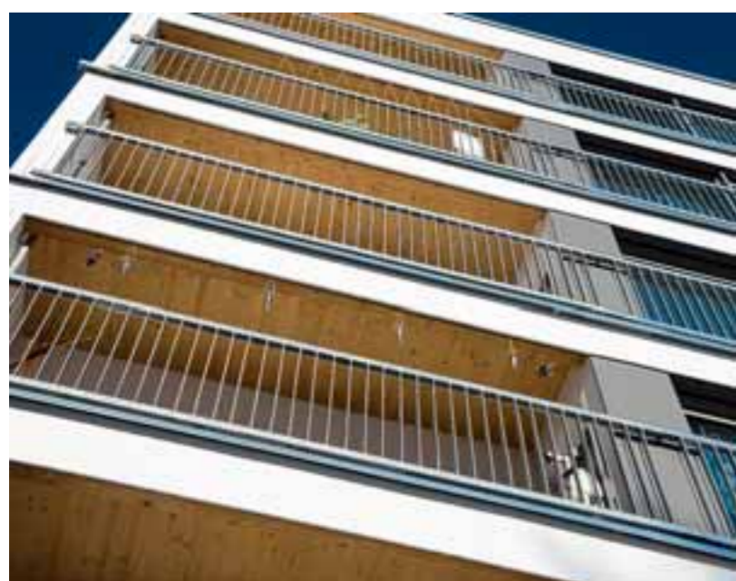
Ausführende Holzbaufirma bei der prämierten Sanierung einer Wohnanlage in der Wohnungsbaugesellschaft Augsburg war die Firma Gump & Maier in Binswangen.
