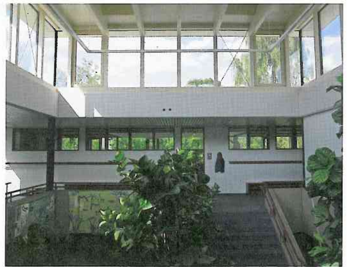
▲ Die geschlossene Dachfläche schützt das Innere vor Überhitzung
