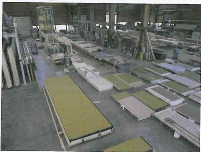
▲ Die neue Holzrahmenbau-Fassade fertigte das Holzbauunternehmen Gump & Maier in seiner Werkhalle fast komplett vor
