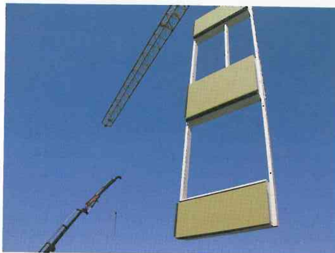
▲ Ein Kran hebt die gebäudehohen Elemente zu ihrer Einbauposition. Aus montagetechnischen Gründen fehlen die Fenster
