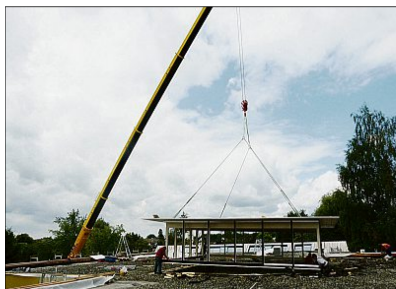
Das neue Oberlichtelement über der Eingangshalle wird aufgesetzt.
