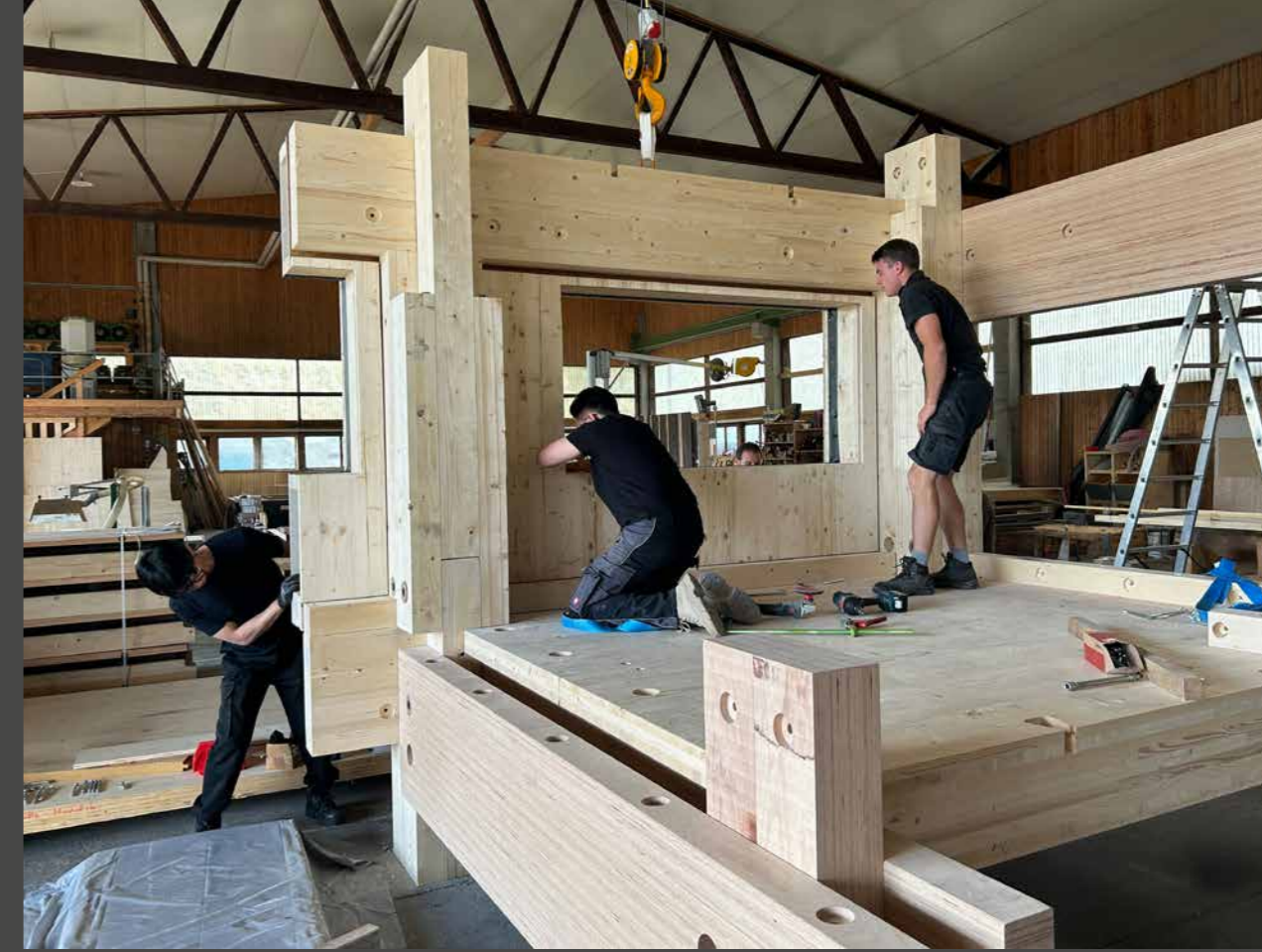
In Teamarbeit entsteht in den Hallen von Gump & Maier das Mockup
