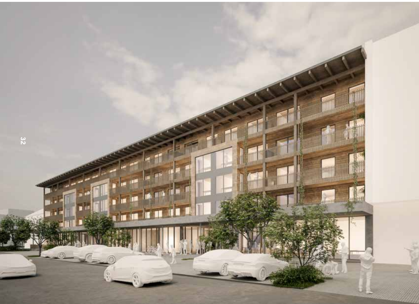
Spargelhalle, Ostseite (HORMUTH architektur)
