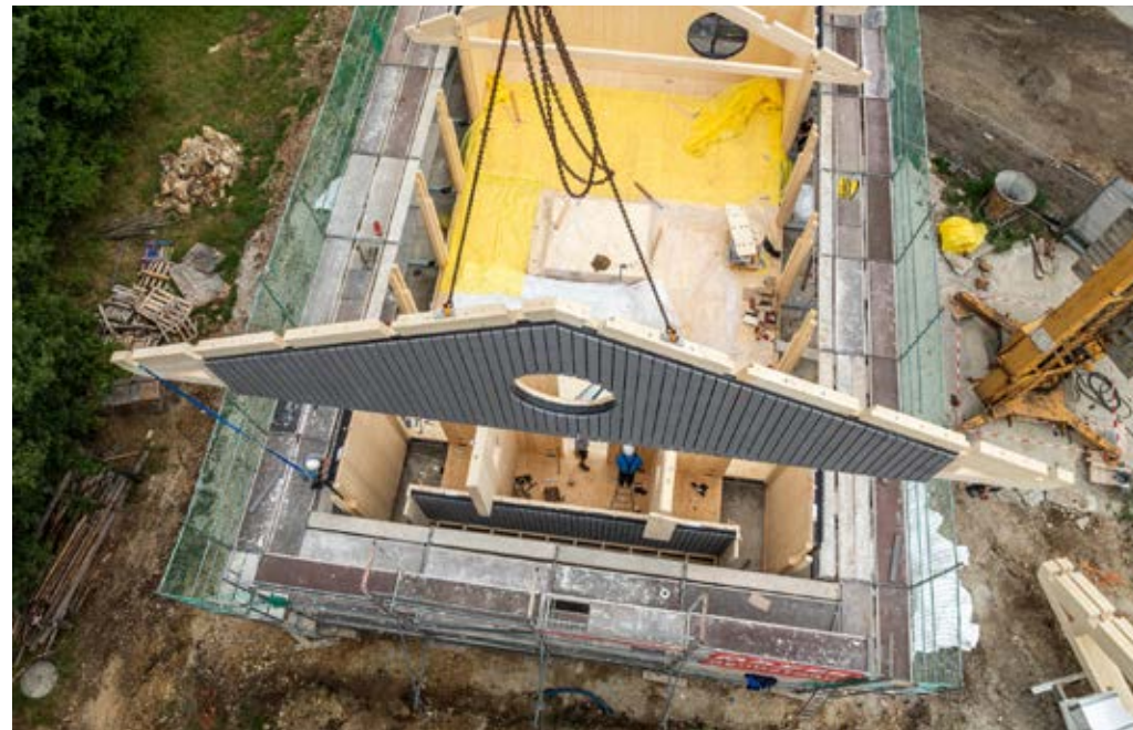
Schutzhaus Michelsberg – Rückbaubare Holz-Hybridkonstruktion aus Skelettstruktur und vorgefertigten Elementen
