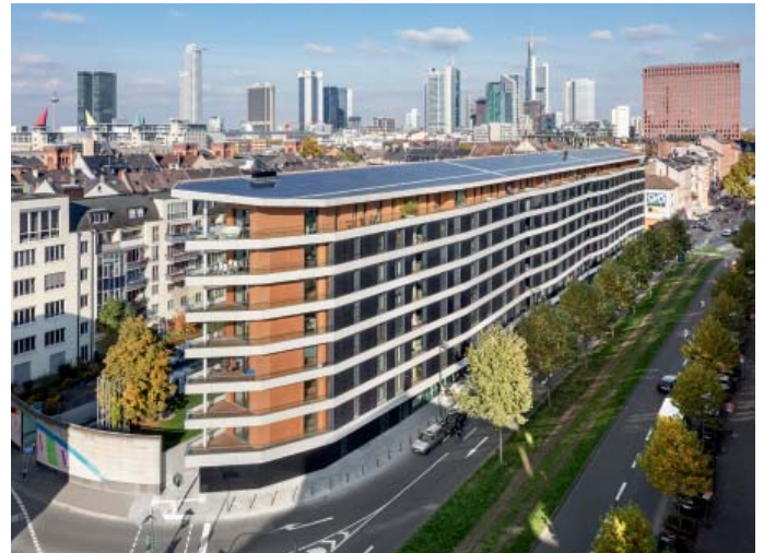
Energiequelle ist das Pultdach: Um ausreichend elektrische Energie über Photovoltaikmodule zu generieren, überragt es allseitig den Baukörper
