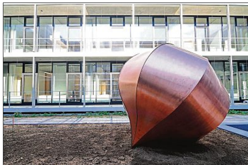
Der zentrale Treppenraum und die „Zwiebel“ im Innenhof.
