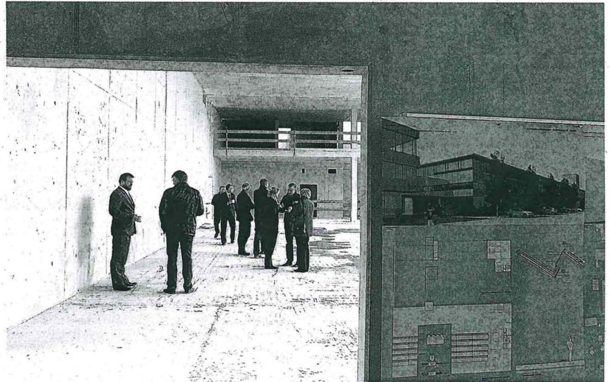
Rundgang durch den Rohbau mit Blick auf den Plan des Gebäudes. Die IWL Landsberg baut derzeit eine erweiterbare Werkstätte für Menschen mit Behinderung in Holzbauweise. Foto: Sibylle Seidl-Cesare
