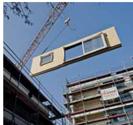
Anlieferung und Montage der Fassadenelemente
