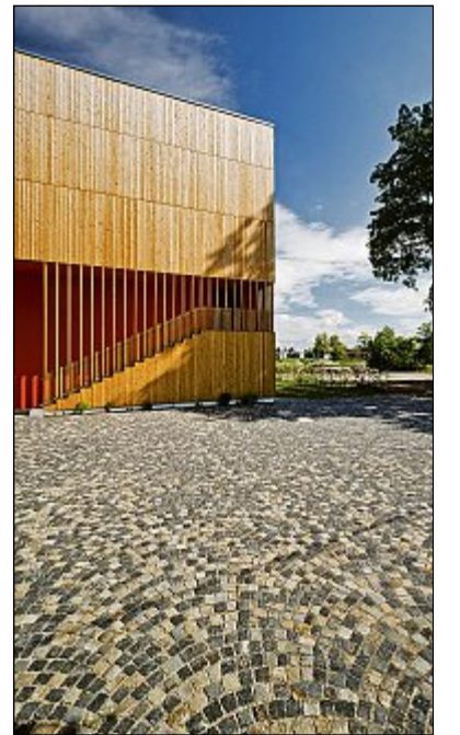
260 Kubikmeter Holz wurden verbaut.
