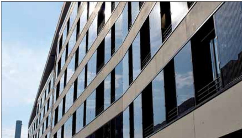
In der schrägen Seitenansicht zeigt sich die leicht gefaltete Südfassade deutlich. Die Faltung bricht zum einen die Länge des Gebäudes, schafft zum anderen aber vor allem die notwendige Tiefe der Wohnungsgrundrisse Foto: Pelkmann/ABC
