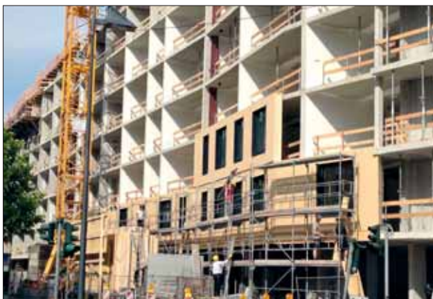
Montage der beidseitig geschlossenen Holzrahmenbau-Elemente samt eingebauter Fenster an das fertige Betonskelett auf der Südseite Foto: Gump & Maier
