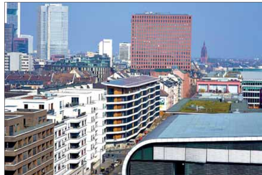
Auffällig ist die Form des Achtgeschossers: Er ist 150 m lang und nur 10 m breit. Das Grundstück galt lange Zeit als unbebaubar und wurde zuvor als Parkplatz genutzt Foto: Ralf H. Pelkmann/ABG Frankfurt Holding
