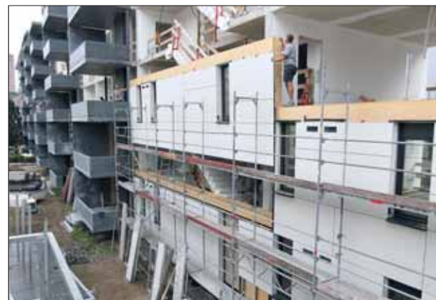
Montage der Holzrahmenbau-Elemente auf der Nordseite. Die Fassade ist gerade konzipiert im Gegensatz zur „gefalteten“ Südfassade Foto: HHS Planer + Architekten AG
