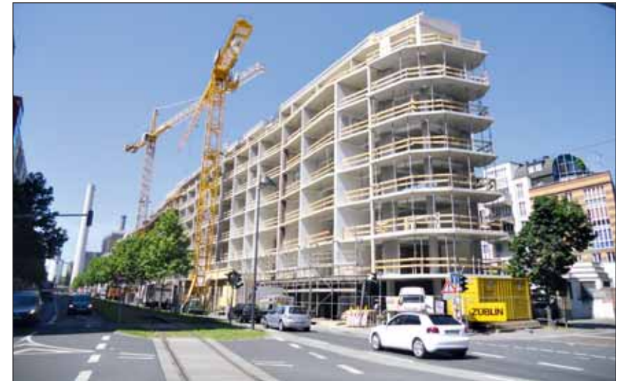
Das Tragwerk des Aktiv-Stadthauses ist ein Stahlbetonskelett- bzw. -schottenbau Foto: HHS Planer + Architekten AG
