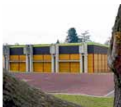
Die Turnhallen-Sanierung schlägt mit 350 000 Euro zu Buche.
