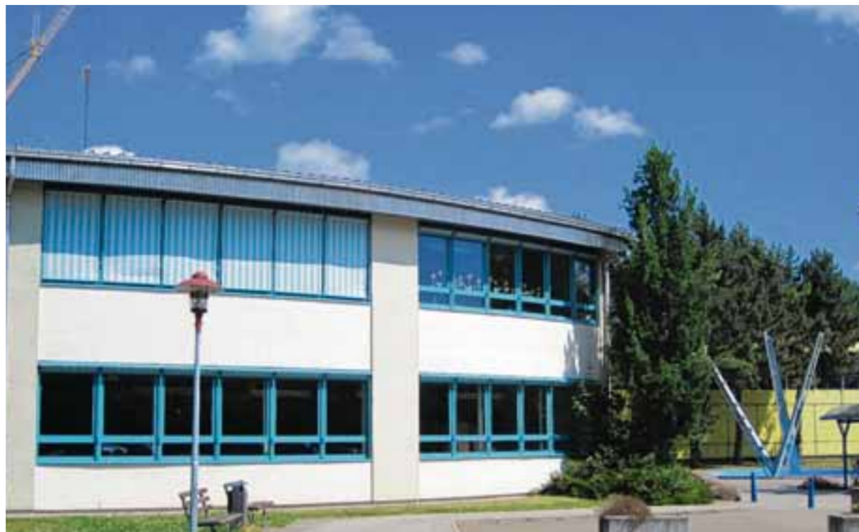
Die Peter-Schweizer-Volksschule in Gundelfingen wird seit 1. Juni 2009 von der Firma „eza!“ betreut. Diese kümmert sich um das kommunale Energiemanagement nach Maßstäben des Klimaschutzes.
