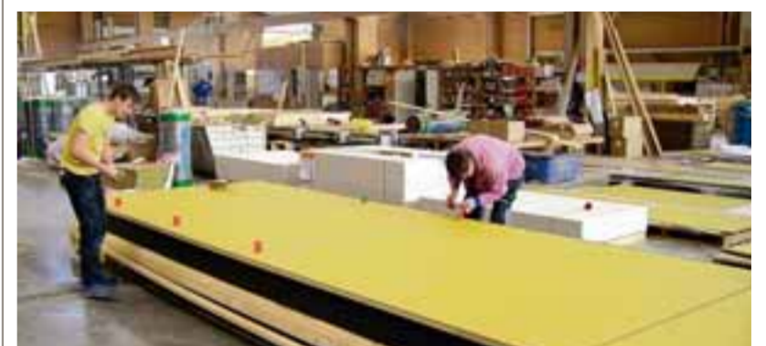
Die Holzrahmenelemente für die neue Verkleidung der Peter-Schweizer-Schule in Gundelfingen wurden von Gump & Maier in Binswangen gefertigt.
